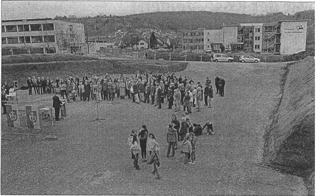
Der Boden ist bereit fürs neue Remshaldener Rathaus. In der auch wegen der Tiefgarage ziemlich ausgedehnten Baugrube oberhalb des Altenpflegeheims wurde gestern am späten Nachmittag der Start des bedeutenden Bauprojekts gefeiert. Bilder: Schneider
