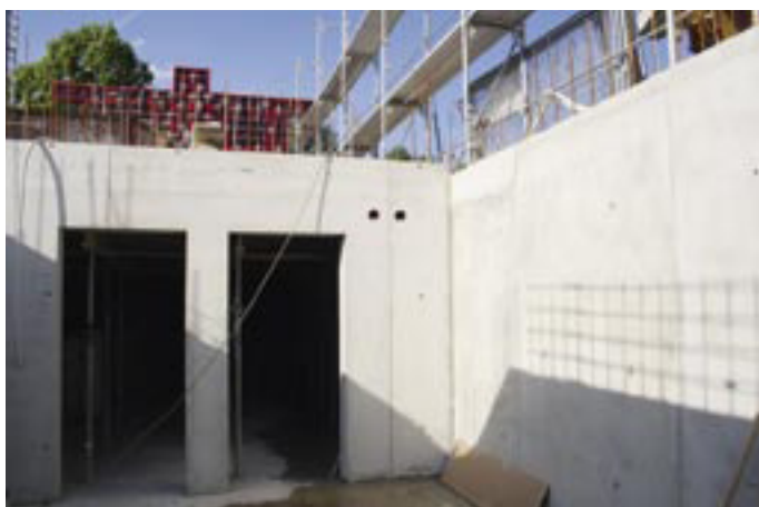
Blick vom Treppenhaus in die zukünftige Toilettenanlage im UG
