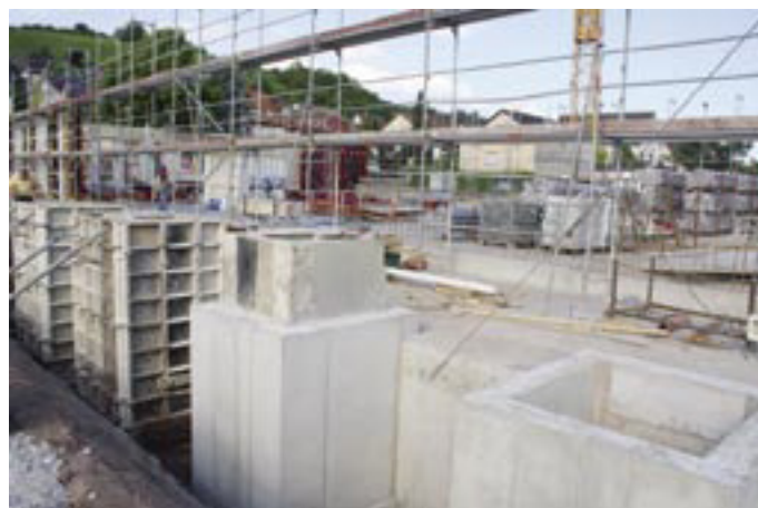
Auf dem zukünftigen Marktplatz sichtbare Lichtschächte
