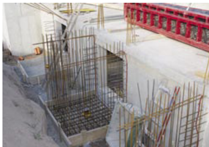
Bewehrung eines Tiefgaragen-Lichtschachts
